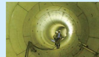
浸水被害を受ける可能性が高い6地区を選定し、重点的に整備しています。写真は完成したバイパス貯留管(加勢川第6排水区)
