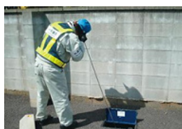
漏水調査の様子
