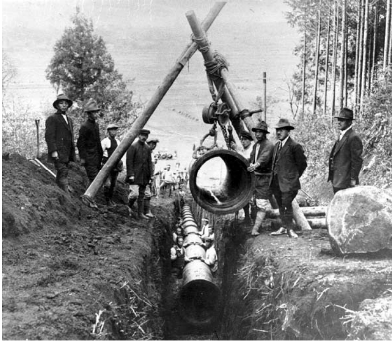
八景水谷送水管布設工事（大正期）
