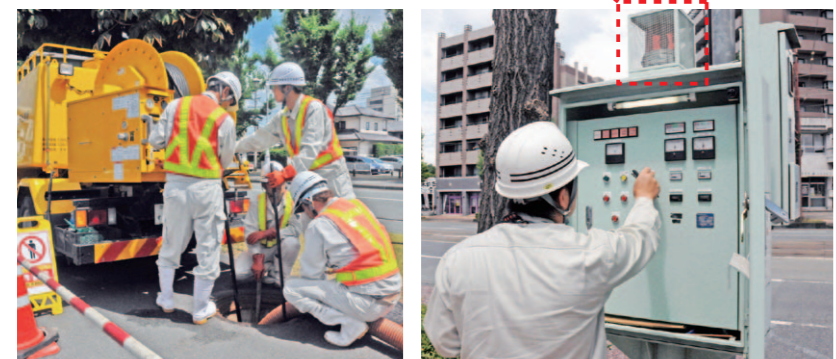
下水管きょの清掃の様子
