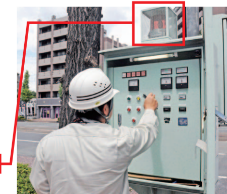
ポンプ場点検の様子
