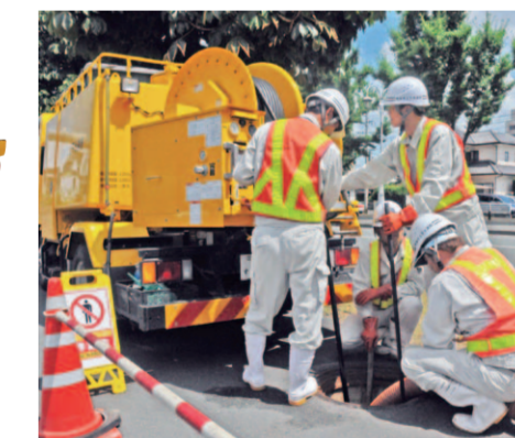
下水管きょの清掃の様子
