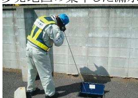
漏水調査の様子
