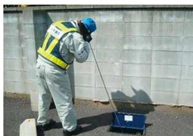
漏水調査の様子
