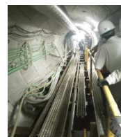
加勢川第6排水区雨水幹線シールド工事
