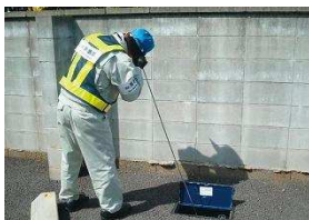
漏水調査の様子
