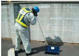
漏水調査の様子
