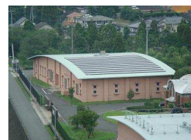
太陽光発電設備(八景水谷送水場)
