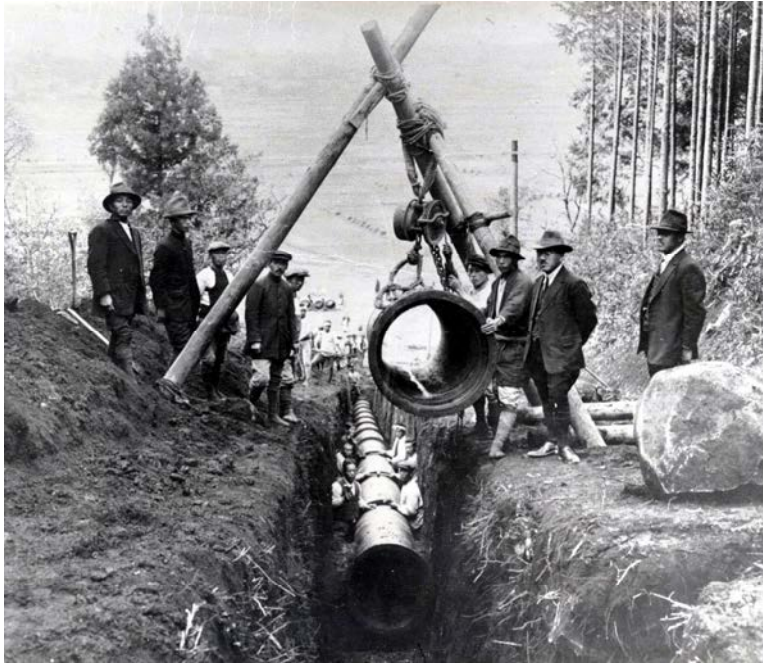
八景水谷送水管布設工事（大正期）
