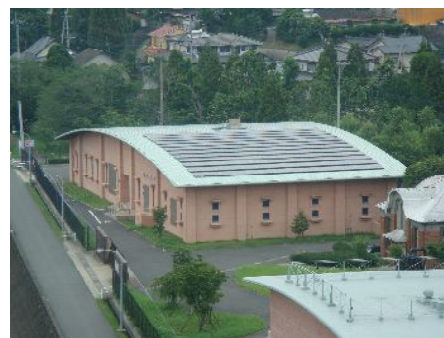
八景水谷送水場太陽光発電設備
