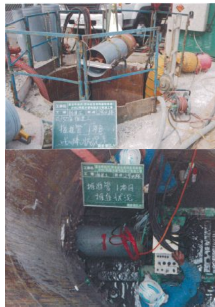
富合町田尻φ150㎜配水管布設及び推進工事
