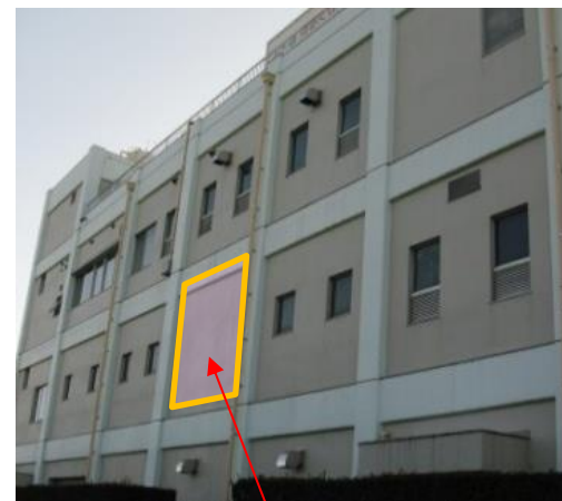
〔中部浄化センター 汚泥処理棟〕
