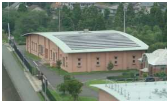
八景水谷送水場
