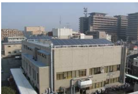
上下水道局別館
