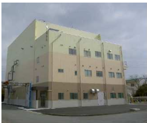
固形燃料化施設
