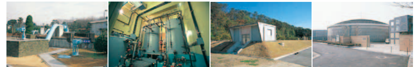
集水槽・調整池 汲み上げた水を一旦ここに集めます。 滅菌設備 次亜塩素酸ナトリウムで滅菌します。 配水池(高台) 配水池(平地) 水使用が集中する時間帯でも水の出が悪くならないよう、常に多量の水を貯えています。
