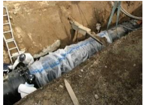
水道管の布設工事
