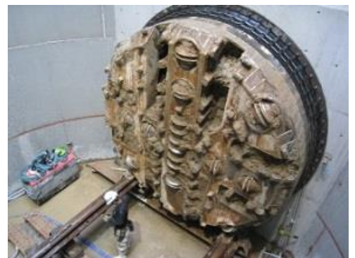
下水道管(雨水管)のシールド工事
