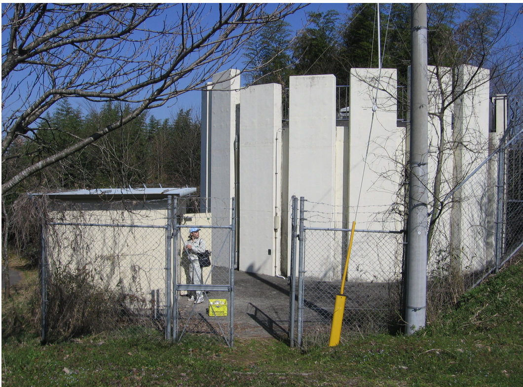
工業用水道配水池
