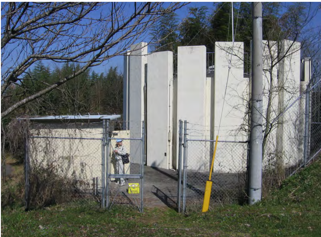
工業用水道配水池
