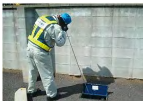
漏水調査の様子
