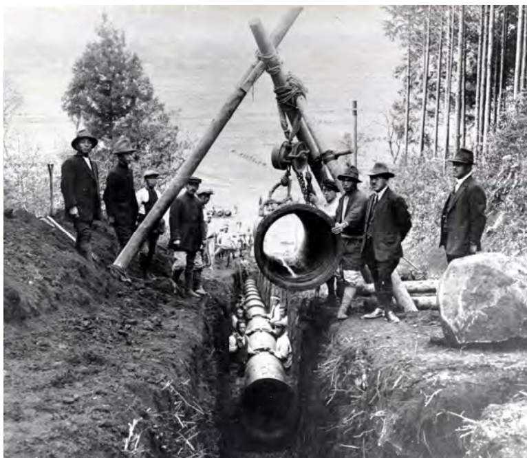
八景水谷送水管布設工事（大正期）
