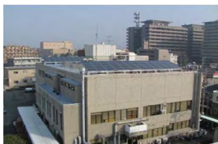
上下水道局別館
