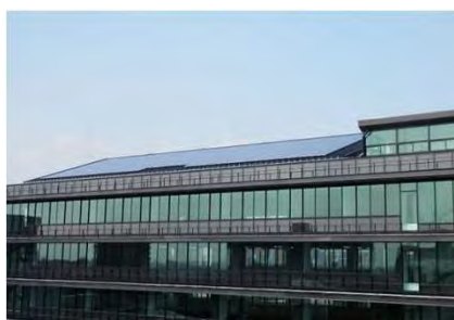
上下水道局本館
