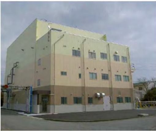
固形燃料化施設
