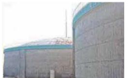
水道管・配水池などの耐震化
