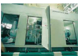
非常用発電設備の整備
