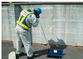
漏水調査の様子
