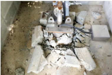
1号井 ポンプ室送水管破損状況
