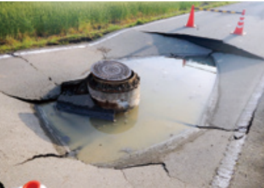
下水道管路の被害
