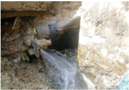
800mm送水管（漏水状況）
