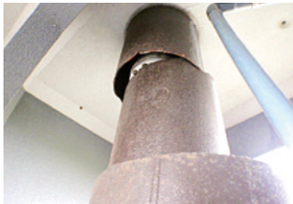
取水施設(沼山津9号井)井戸ケーシング損傷
