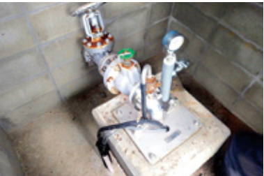
3号井 ポンプ周り配管状況(沈下・歪み)
