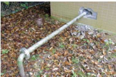
1号井 ポンプ室送水管破損状況
