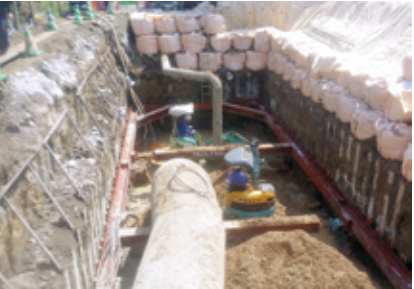
秋田配水区配水本管1350mm損傷
