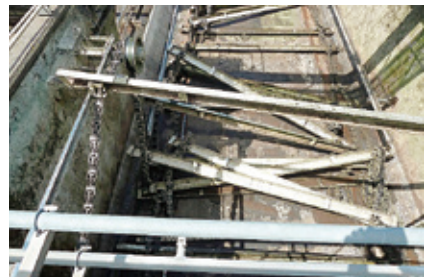
汚泥掻き寄せ機脱落
