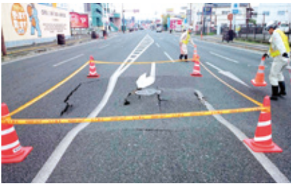
緊急輸送路内陥没
