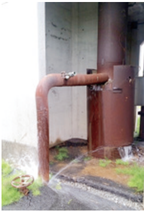
取水施設(秋田6号井)井戸ケーシング損傷
