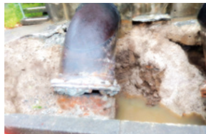
分水タンク流出管からの漏水
