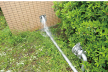
3号井 ポンプ室送水管破損状況
