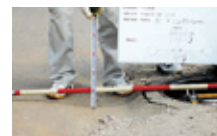
道路陥没(高さ100mm)
