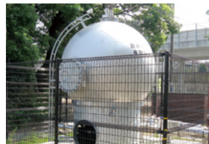
貯水機能付給水管(災害用給水タンク)
