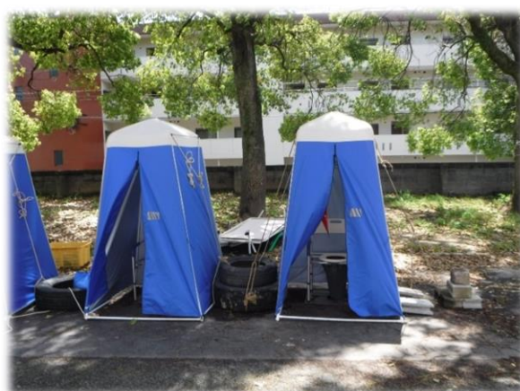
災害用マンホールトイレ
