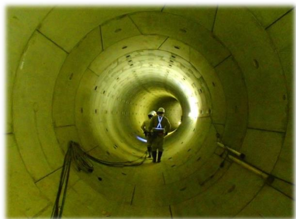
完成したバイパス貯留管（加勢川第 6 排水区）
