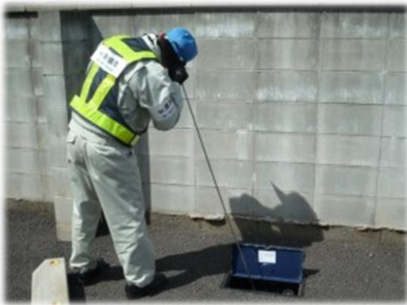
漏水調査の様子
