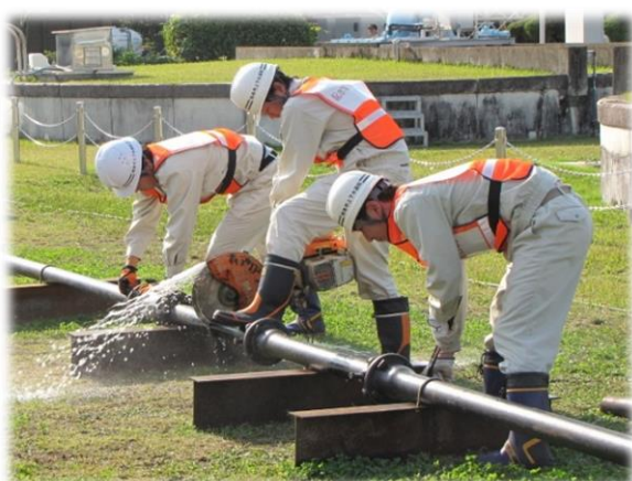
水道管の復旧訓練
