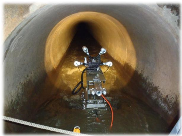
下水道管路のカメラ調査
