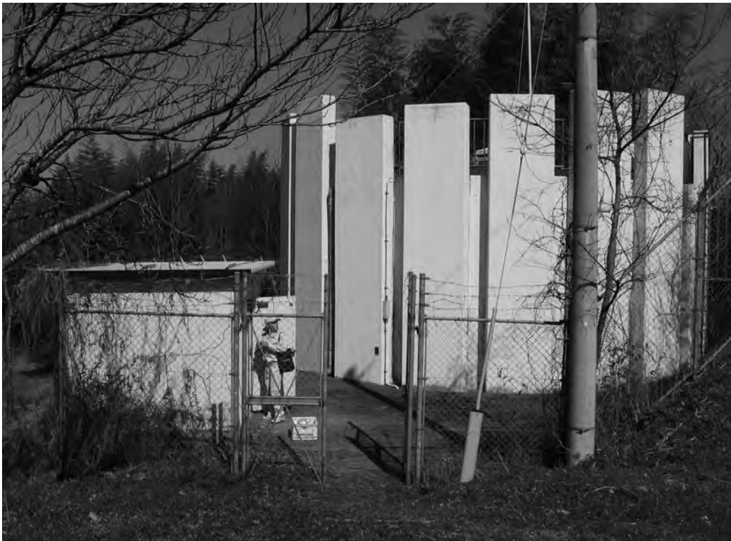
工業用水道配水池
