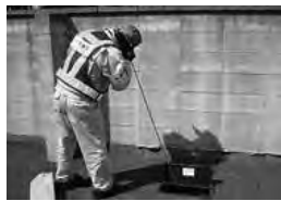
漏水調査の様子
