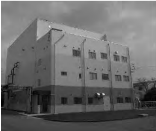
固形燃料化施設
