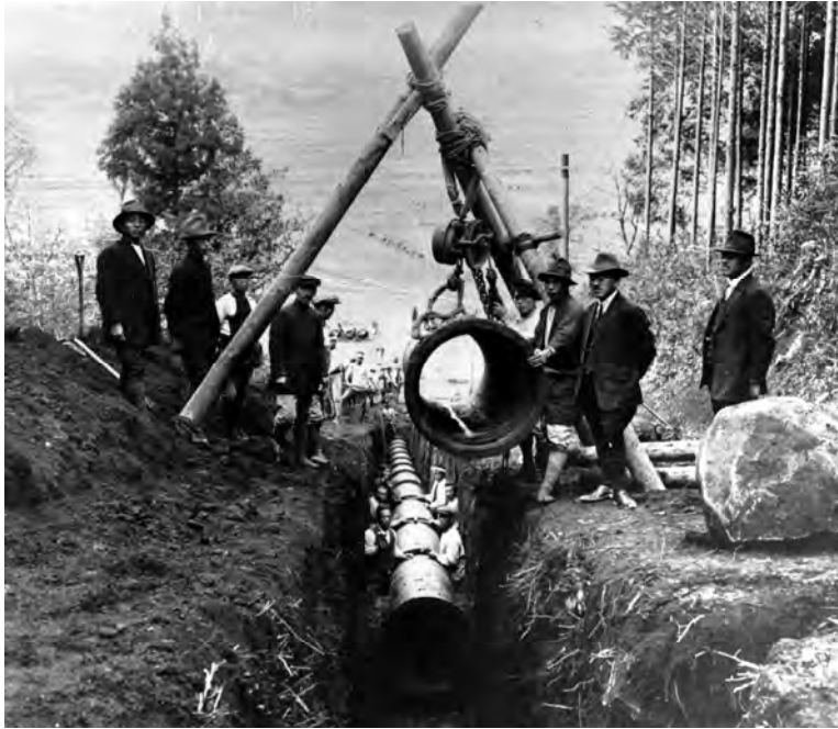
八景水谷送水管布設工事（大正期）
