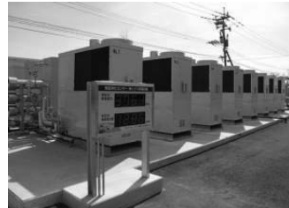
消化ガス発電設備 (上)中部浄化センター消化ガス発電機(エンジン) (下)東部浄化センター消化ガス発電設備(外観)
