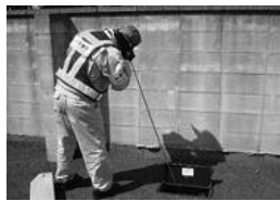
漏水調査の様子
