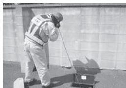
漏水調査の様子
