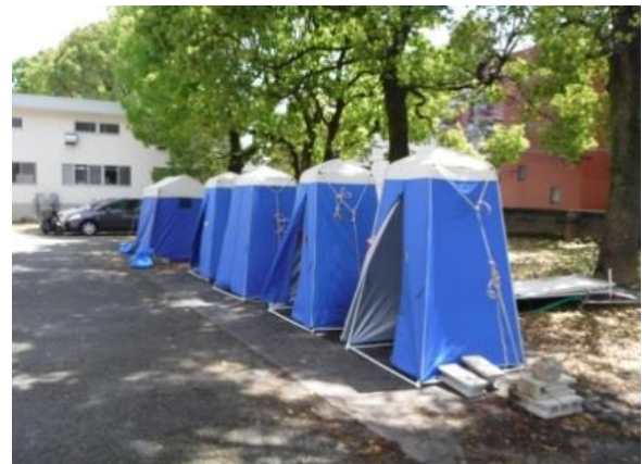
写真 4-3-7 マンホールトイレ
