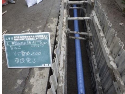
写真 4-3-3 下水道管路の新設工事
