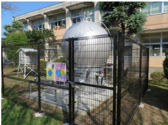
写真 4-3-6 貯水機能付給水管
