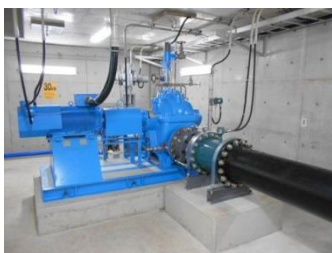
写真 4-3-11 小水力発電 （戸島送水場）
