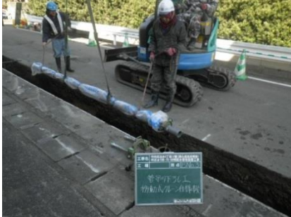
写真 4-3-2 水道管路の布設替え工事
