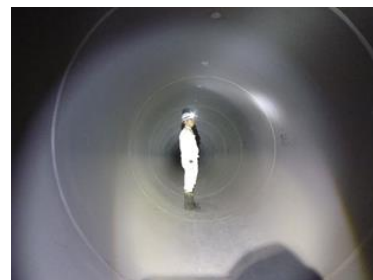
写真 4-2-1 雨水バイパス管
