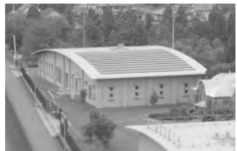
八景水谷送水場
