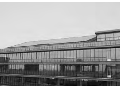
上下水道局本館
