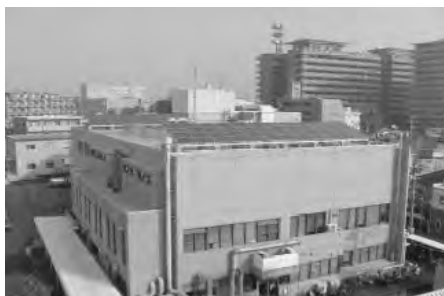
上下水道局別館
