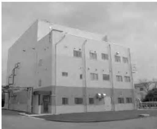
固形燃料化施設
