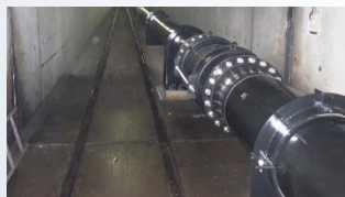
耐震化済の水道基幹管路
