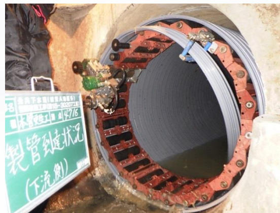
下水道管路の改築更新
