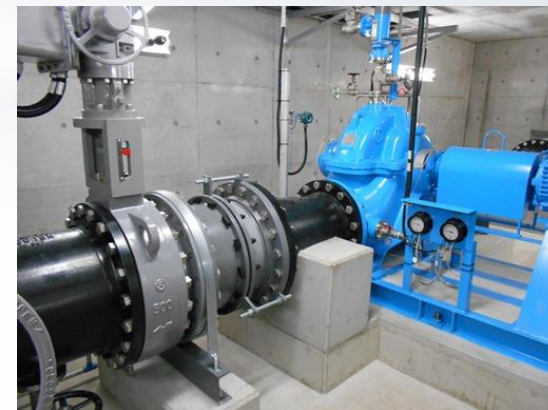
小水力発電設備
