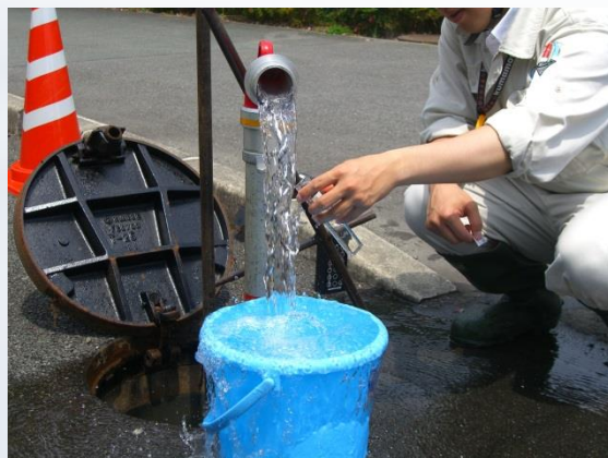
水道管の洗管作業
