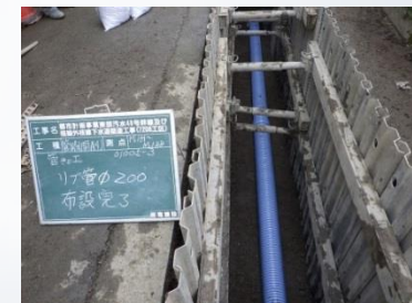
下水道管の布設工事
