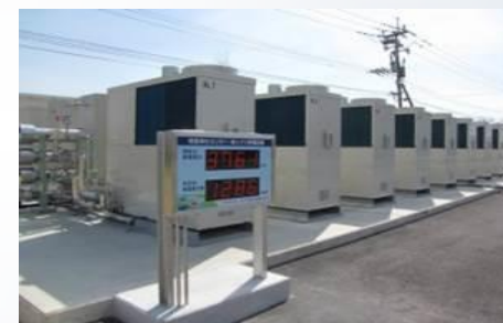
消化ガス発電設備
