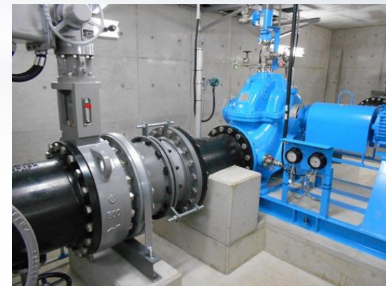
小水力発電設備
