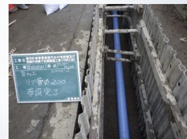
下水道管の布設工事
