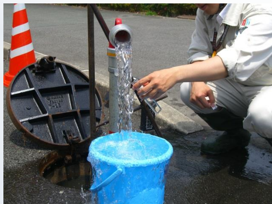
水道管の洗管作業
