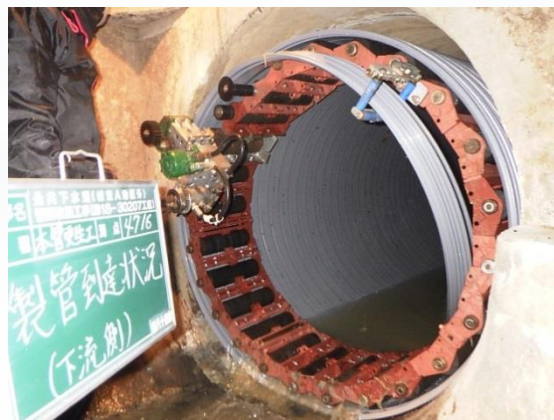
下水道管路の改築更新
