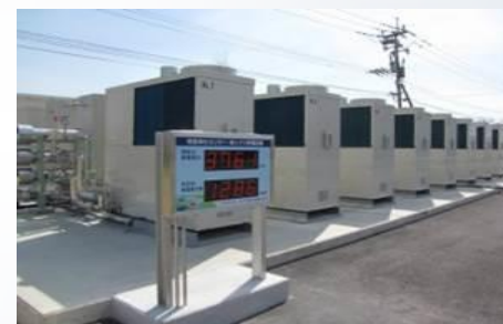
消化ガス発電設備
