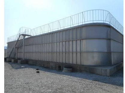
写真 4-3-4 災害対策用貯水施設 (南部送水場)
