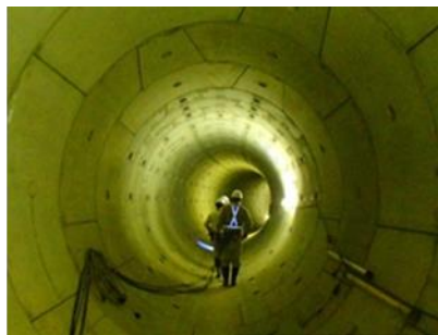
雨水バイパス貯留管
