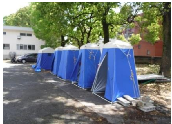
写真 4-3-7 マンホールトイレ
