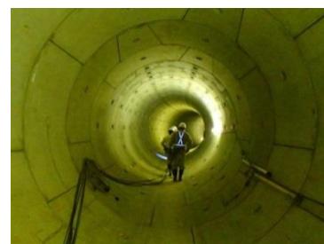
写真 4-2-1 雨水バイパス貯留管
