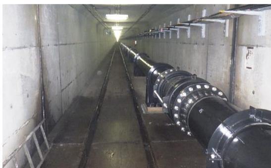
耐震化した水道の基幹管路
