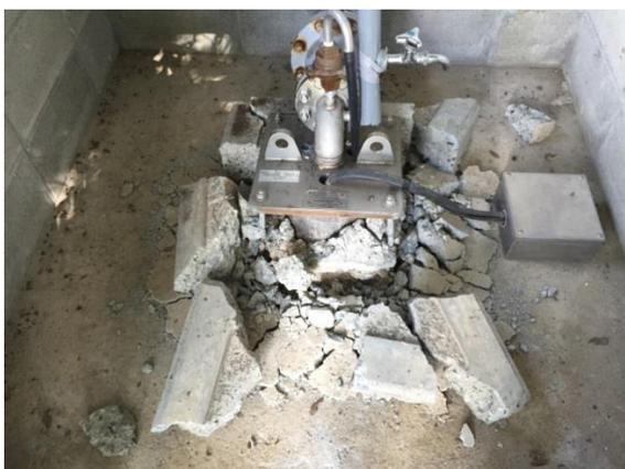
熊本地震による井戸ポンプの被害
