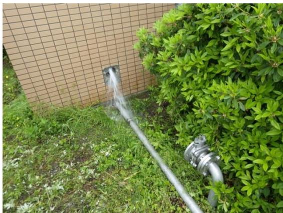
熊本地震による送水管の被害
