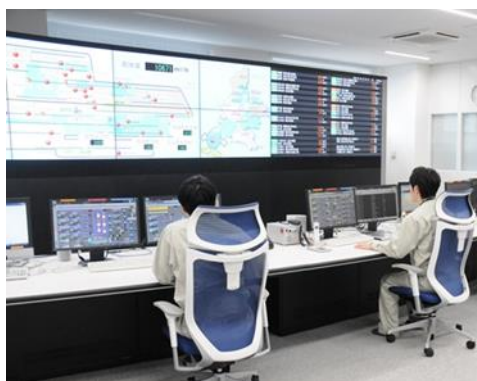
写真 2-1-1 水運用センター
