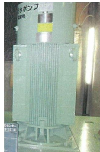
更新した污水ポンプ (中部浄化センター)
