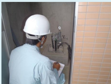
井戸ポンプの点検
