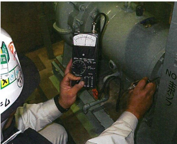
ポンプ等設備の点検調査
