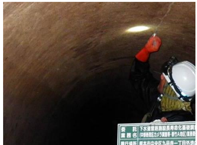
下水道管路内部の点検調査
