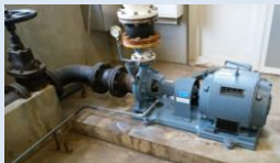
配水ポンプ（西梶尾配水場） R 5 更新予定
