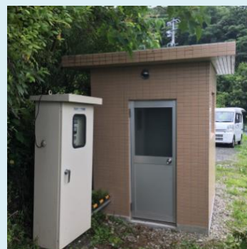
更新後の建屋（井戸ポンプ）
