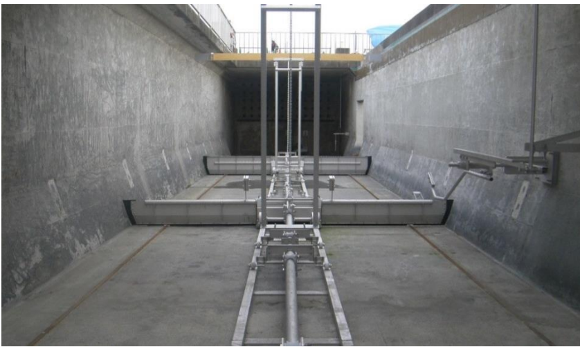
更新した汚泥掻き寄せ機
