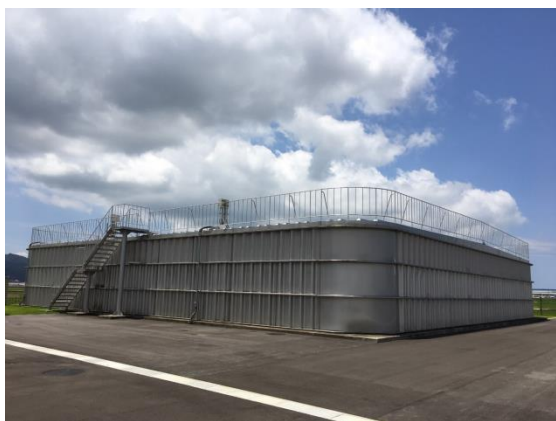
南部送水場の貯水施設
