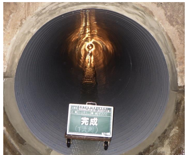
下水道管路の改築更新工事
