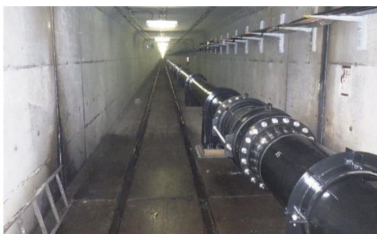
耐震化した水道の基幹管路
