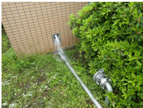
熊本地震による送水管の被害
