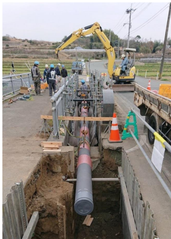
水道管路の更新工事
