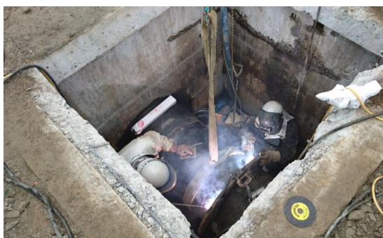
熊本地震の被害を受けた水道管路の復旧
