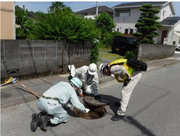
下水道管路の点検調査
