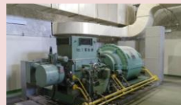
送風機（南部浄化センター） R 2 更新予定
