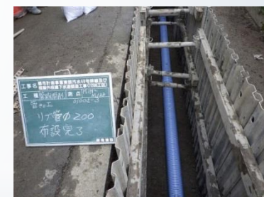
下水道管の布設工事
