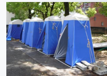
マンホールトイレ
