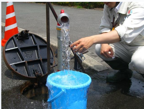
水道管の洗管作業
