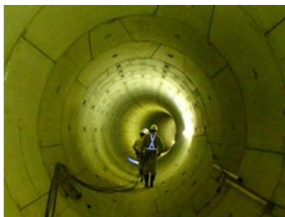
雨水バイパス貯留管
