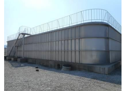
写真 4-3-4 災害対策用貯水施設 (南部送水場)
