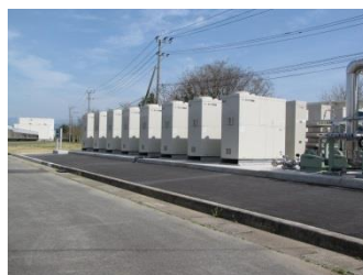
写真 4-3-12 消化ガス発電 （東部浄化センター）
