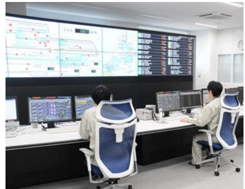
写真 2-1-1 水運用センター
