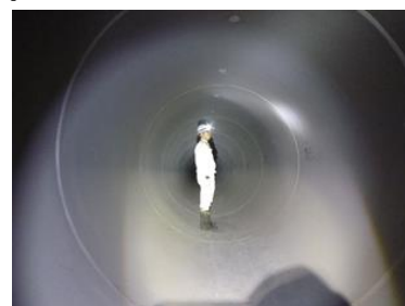
写真 4-2-1 雨水バイパス管
