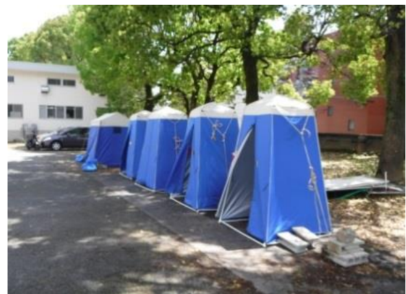
写真 4-3-7 マンホールトイレ
