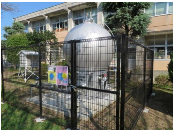
写真 4-3-6 貯水機能付給水管
