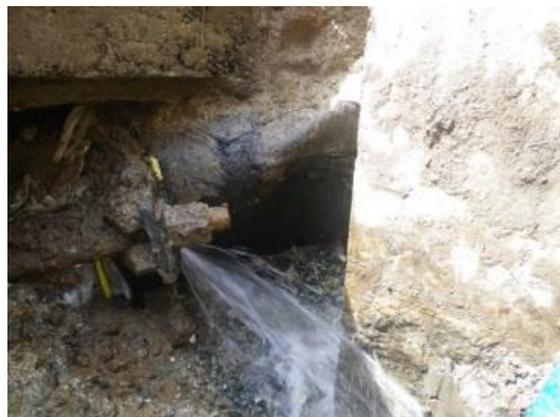
写真 3-8-4-1 熊本地震時における漏水の状況 (沼山津送水管 口径 800mm)
