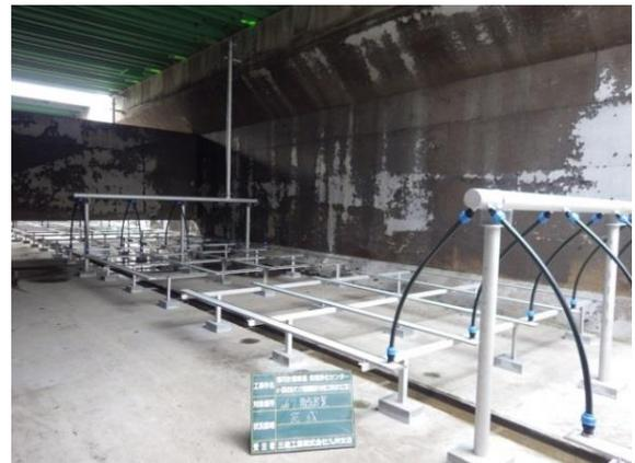
写真 4-3-10 超微細式散気装置\*（東部浄化センターA系統）
