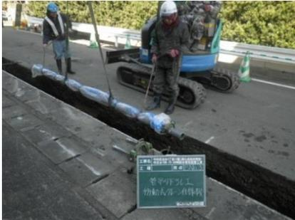
写真 4-3-2 水道管路の布設替え工事
