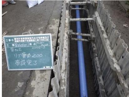
写真 4-3-3 下水道管路の新設工事
