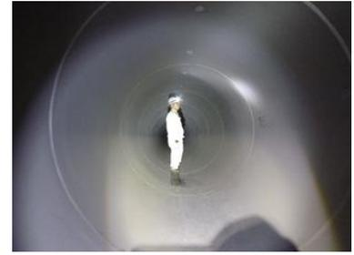
写真 4-2-1 雨水バイパス管
