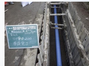
下水道管の布設工事
