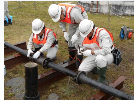
上下水道局防災訓練
