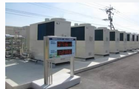
消化ガス発電設備
