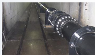
耐震化済の水道基幹管路
