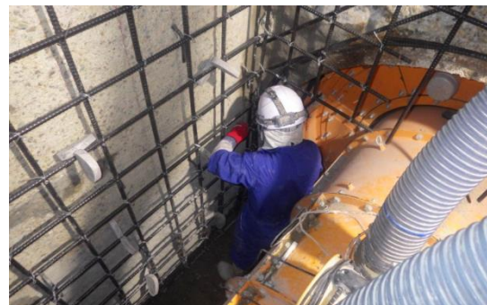
マンホールの耐震化工事
