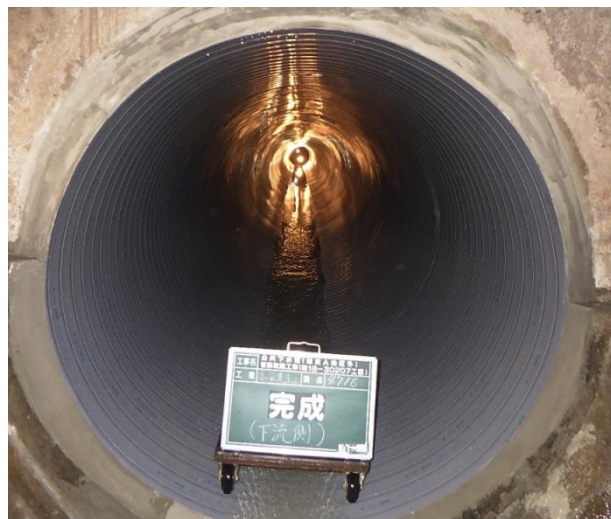
下水道管路の改築更新工事
