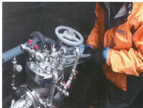
減圧弁の分解整備
