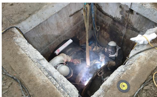
熊本地震の被害を受けた水道管路の復旧
