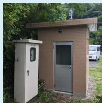
更新後の建屋（井戸ポンプ）
