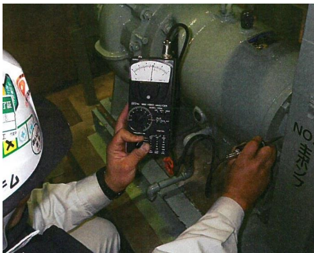
ポンプ等設備の点検調査
