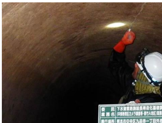
下水道管路内部の点検調査
