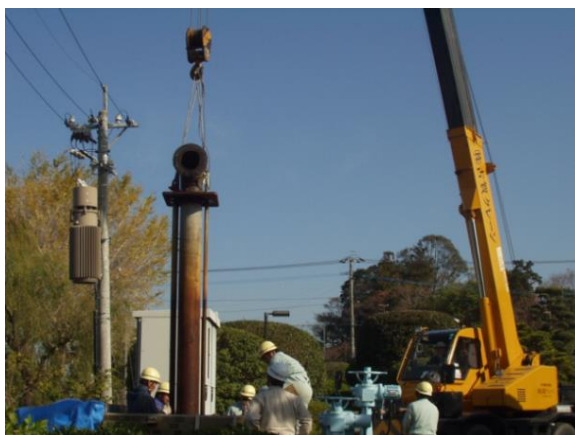
井戸の更生工事
