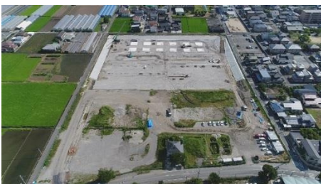
調整池（坪井川第3排水区）
