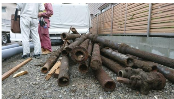
更新工事により取り除かれた老朽管
