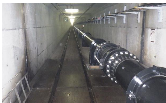
耐震化した水道の基幹管路
