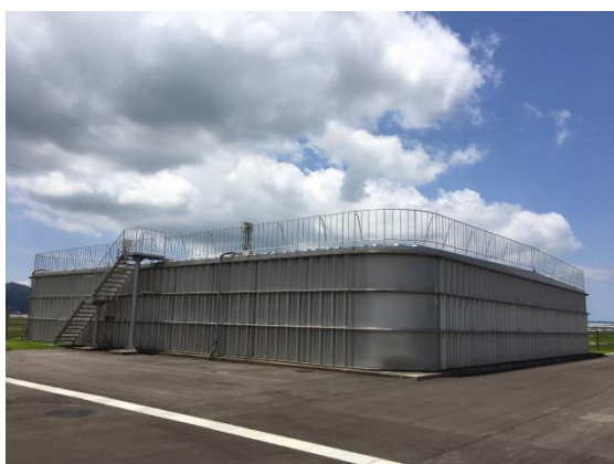
南部送水場の貯水施設
