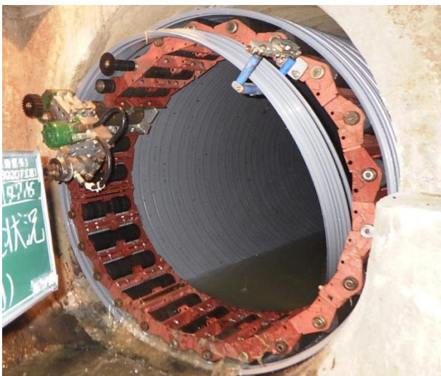
下水道管路の改築更新工事
