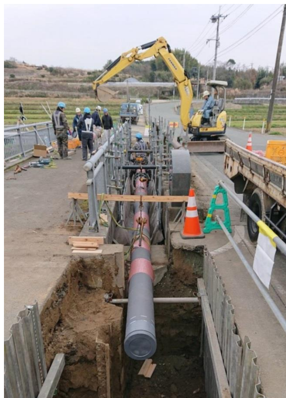
水道管路の更新工事
