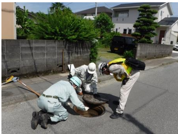
下水道管路の点検調査
