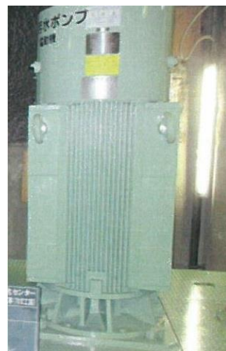
更新した污水ポンプ (中部浄化センター)
