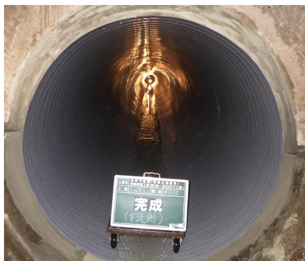
下水道管路の改築更新工事
