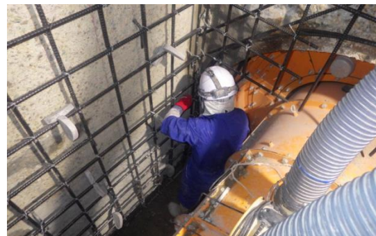
マンホールの耐震化工事
