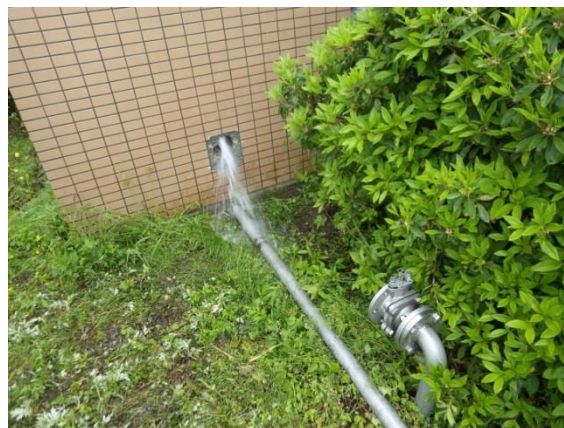
熊本地震による送水管の被害
