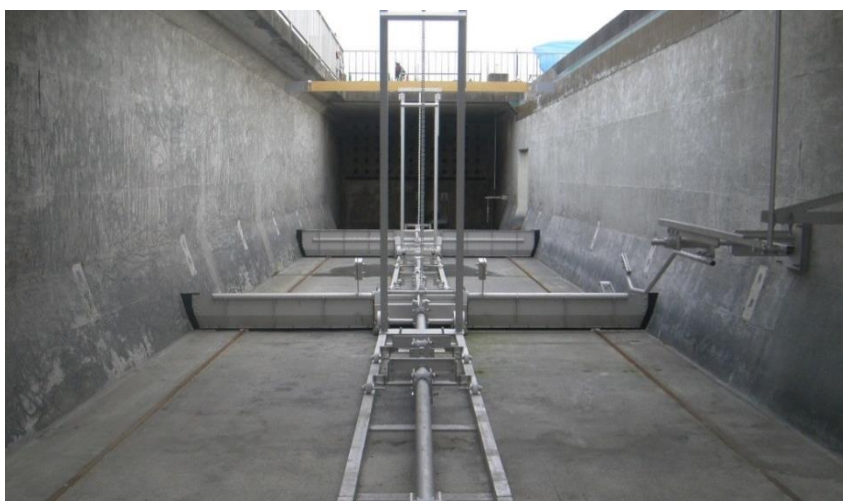
更新した汚泥掻き寄せ機
