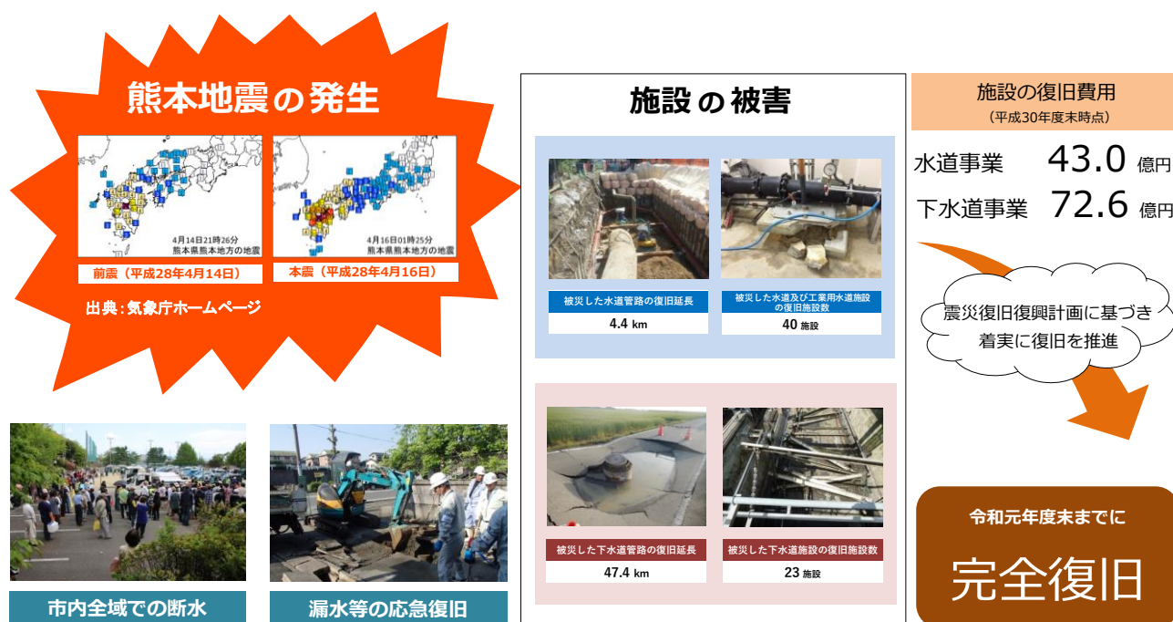
図 3-4-1-1 熊本地震の被害及び復旧状況
