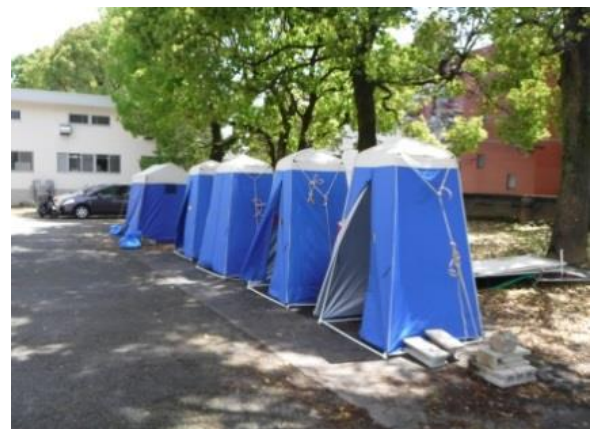
写真 4-3-7 マンホールトイレ
