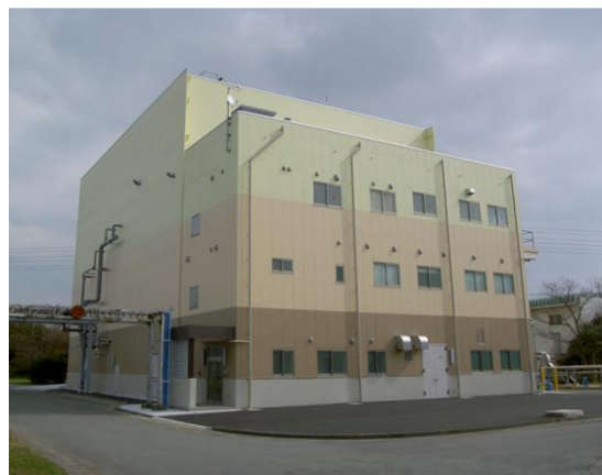
写真 4-3-13 下水汚泥固形燃料化施設 (南部浄化センター)
