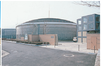
配水池(高台) 水使用が集中する時間帯でも水の出が悪くならないよう、常に多量の水を貯えています。
