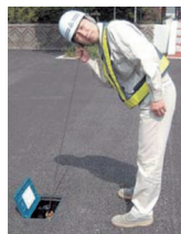
漏水調査（音聴棒）
