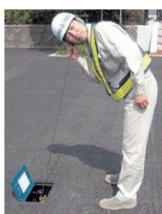
漏水調査（音聴棒）
