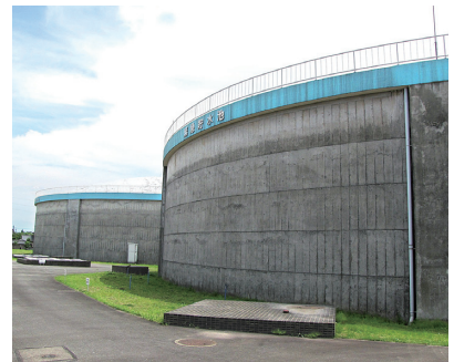
配水池(災害対策用貯水施設) 地震発生時、緊急遮断弁によって配水池の水を確保します
