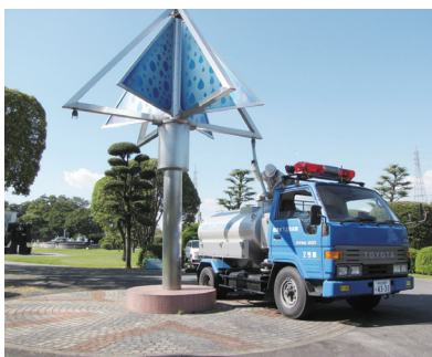
応急給水塔と給水車 災害発生時、給水車への充水拠点としての役割を果たします
