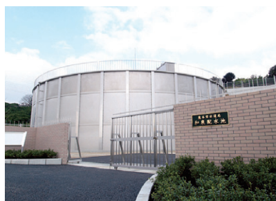
和泉配水池 築造平成18年1月
