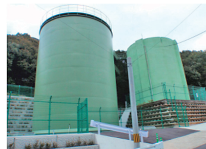
島崎配水池 築造平成22年7月
