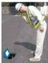
漏水調査（音聴棒）
