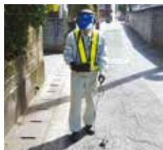
漏水調査（漏水探知）
