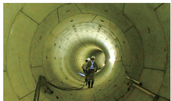
完成したバイパス貯留管(加勢川第6排水区)
