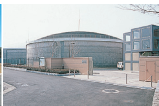
配水池(高台) 水使用が集中する時間帯でも水の出が悪くならないよう、常に多量の水を貯えています。
