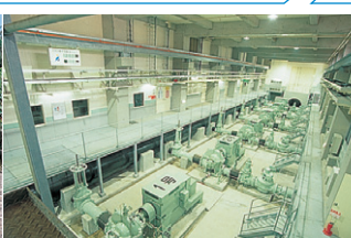
配水ポンプ ポンプで圧力をかけて、水をみなさんのところ(家庭)へお届けしています。
