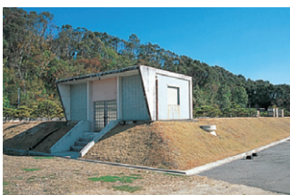
配水池(高台) 水使用が集中する時間帯でも水の出が悪くならないよう、常に多量の水を貯えています。
